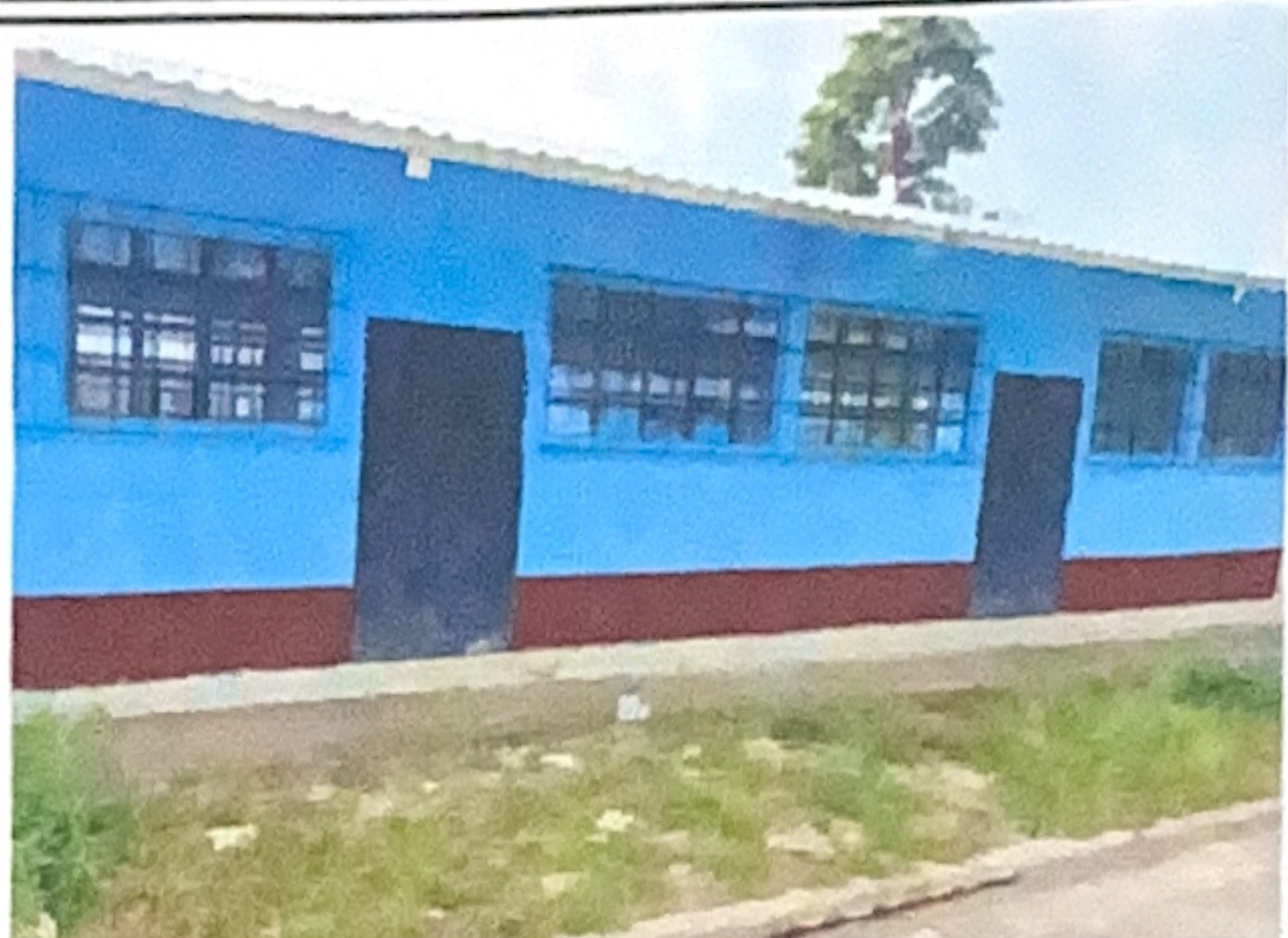
Foto 2: Se coloco los balcones y se coloco las puertas.
