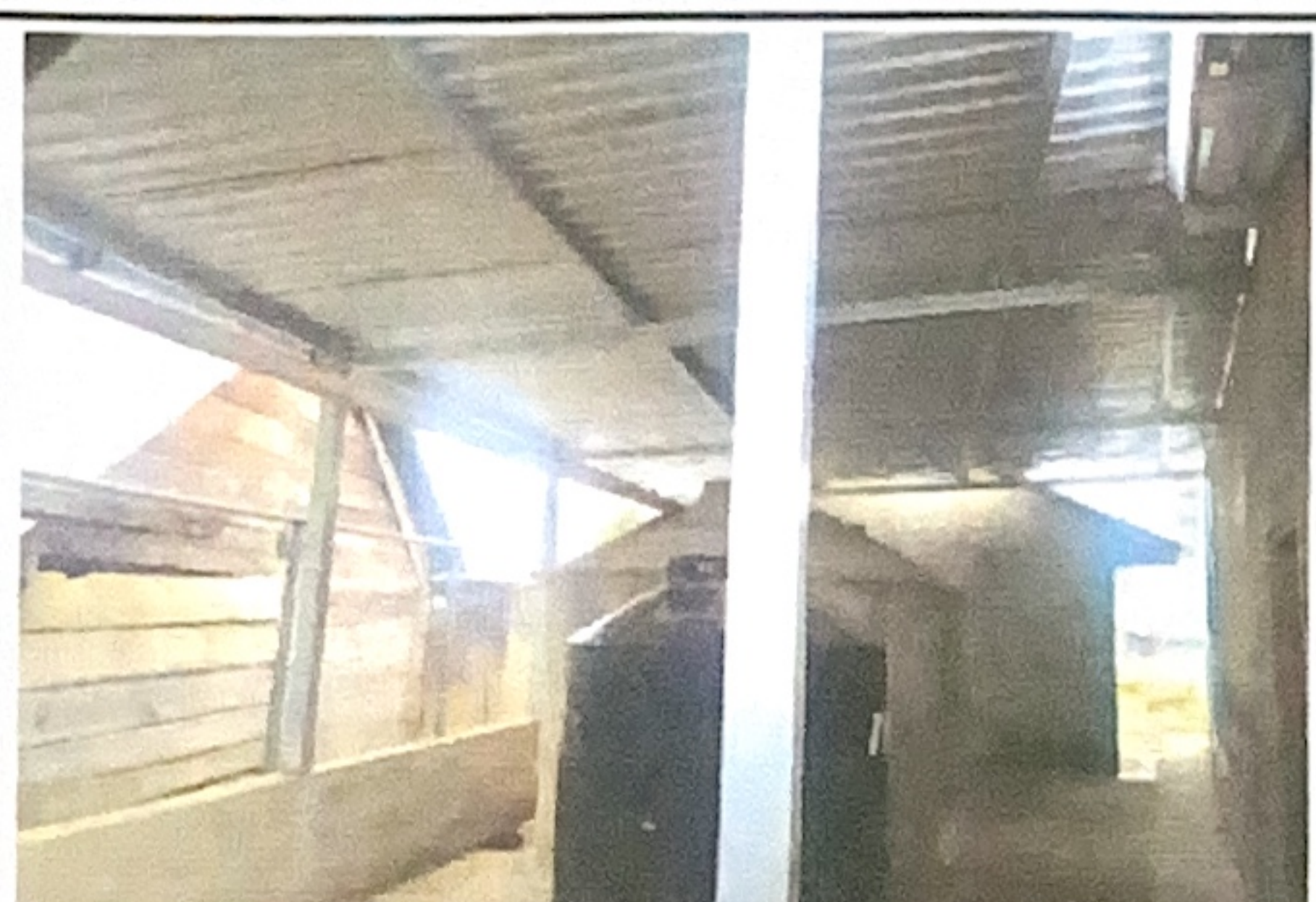
Foto 3: Se entecho el lugar de los tinacos.
